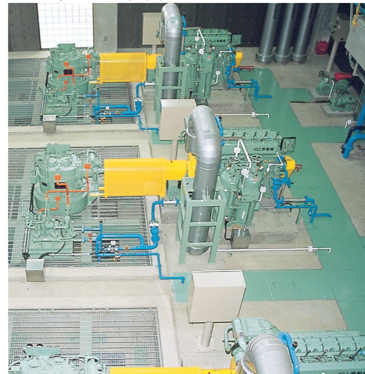
雨水排水機用直交軸歯車装置（ポンプ場） Bevel reduction gear for water drainage at pump station
